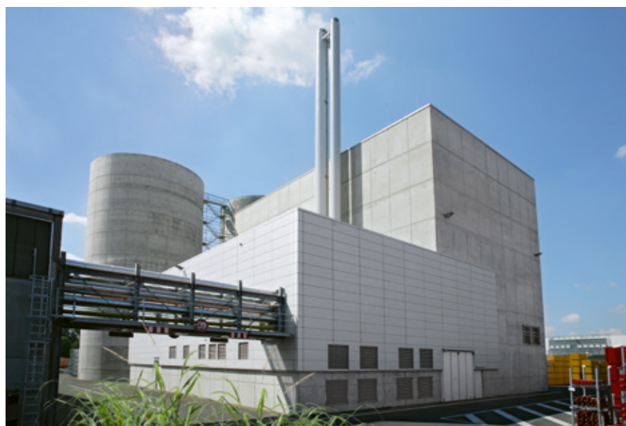
Biomassekraftwerk am Standort Weißenhorn
