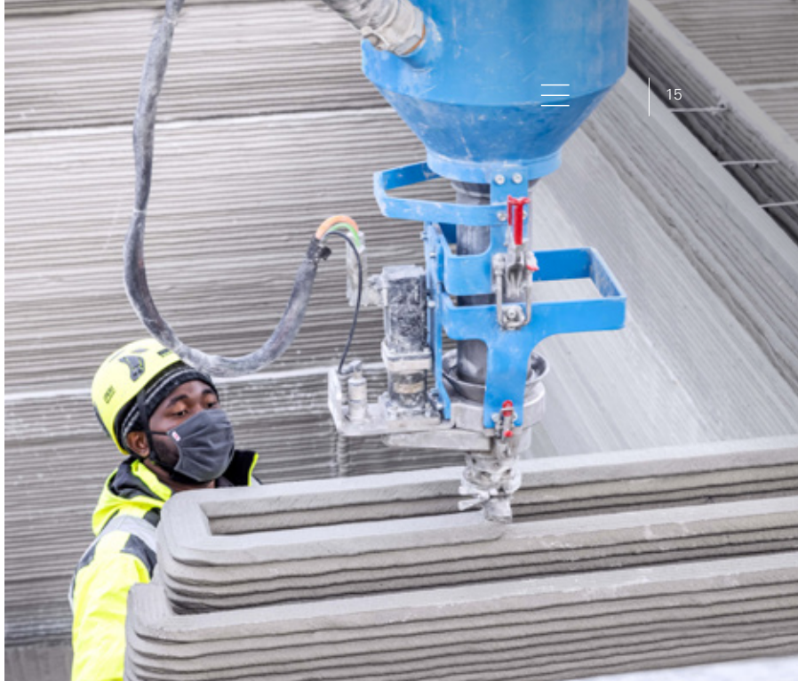
Eine neue, innovative Art des Bauens: 3D Construction Printing
